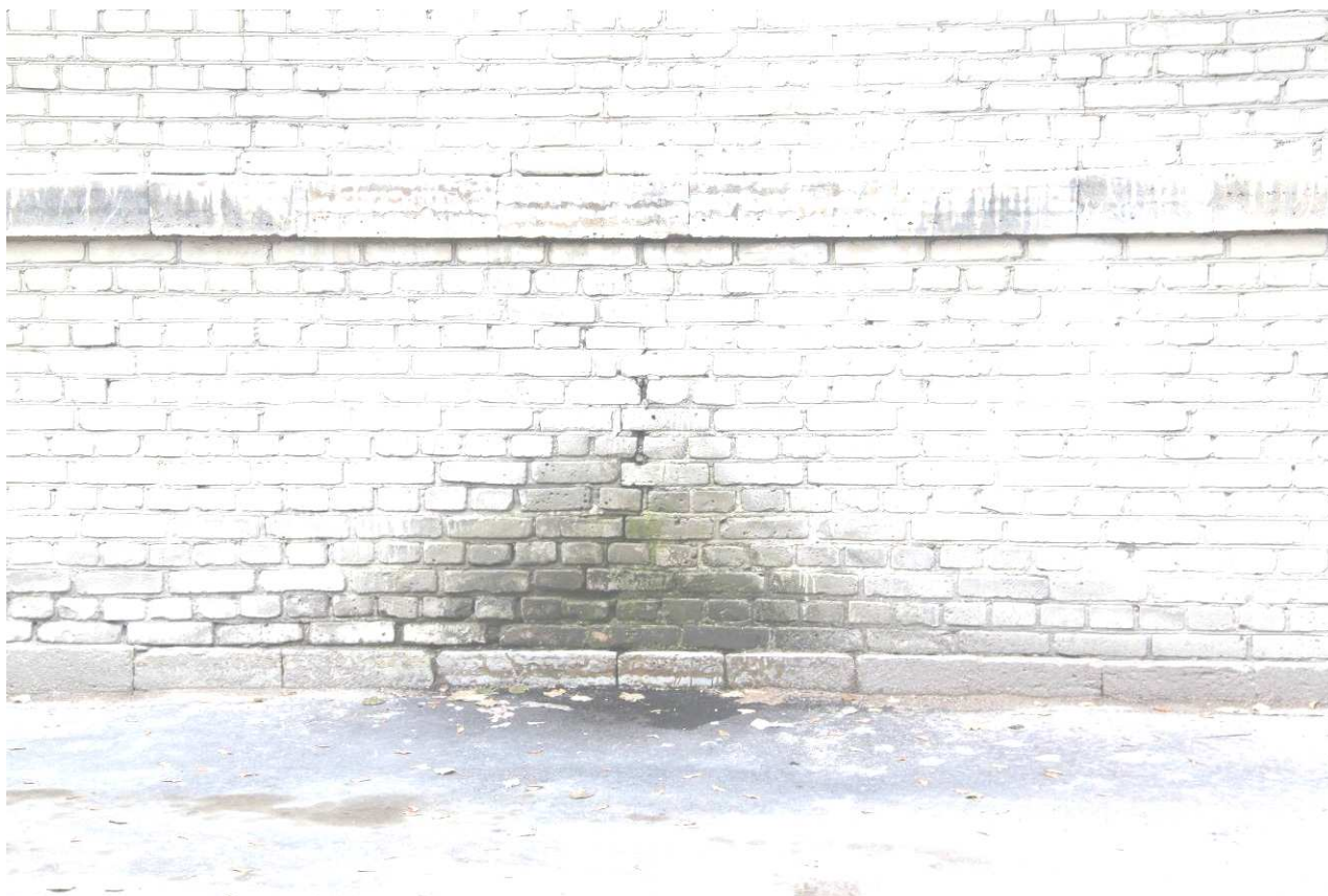
Рис. 13. Влажностные повреждения стен и развитие плесени
