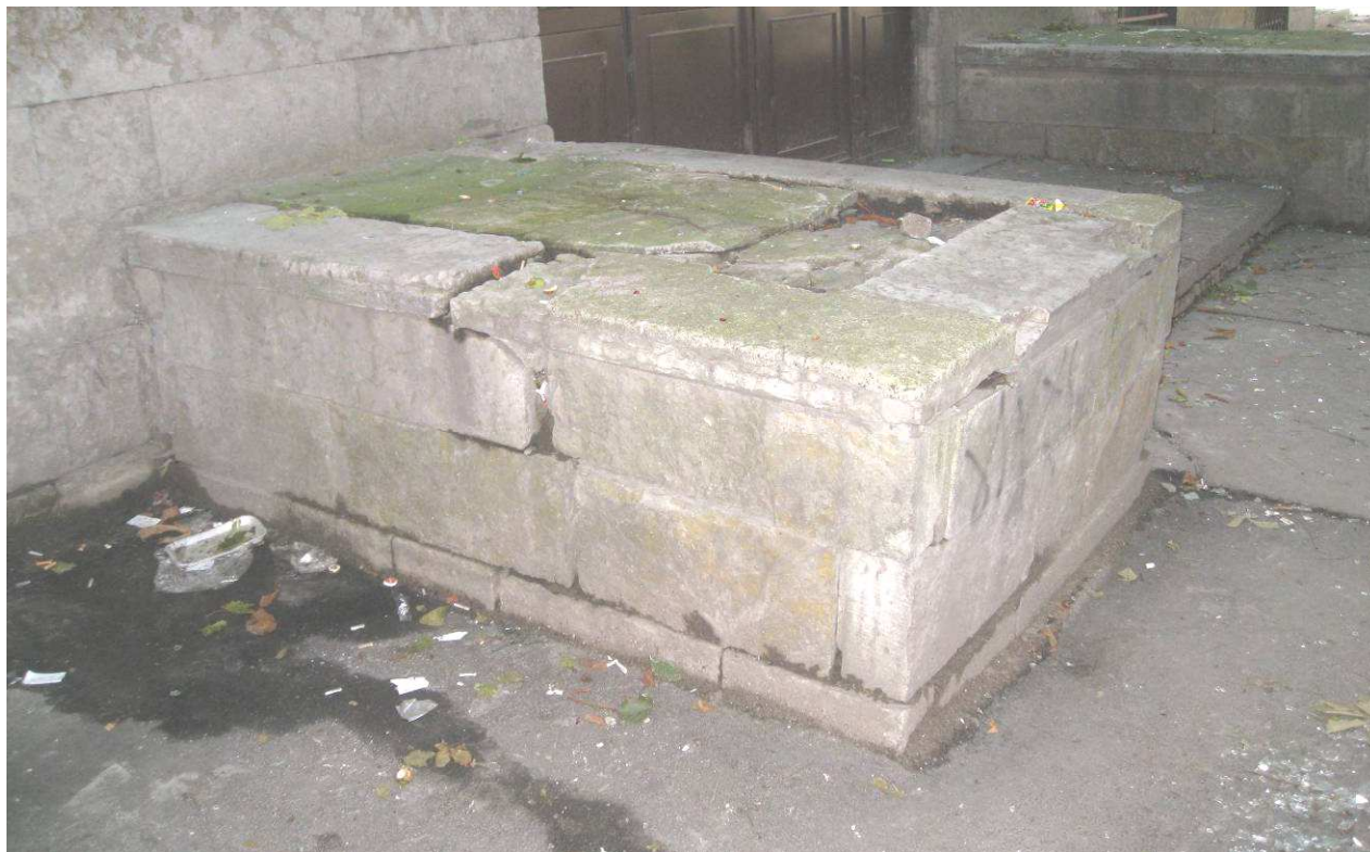
Рис. 14. Крыльцо главного входа (со стороны восточного фасада)
