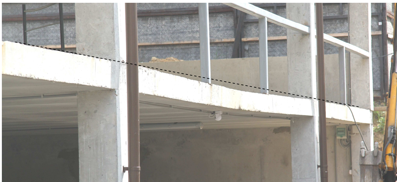
Рис. 3.3. Деформации перекрытия
