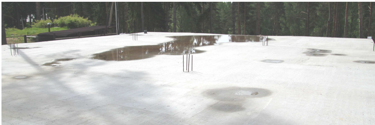
Рис. 3.4. Деформации покрытия
