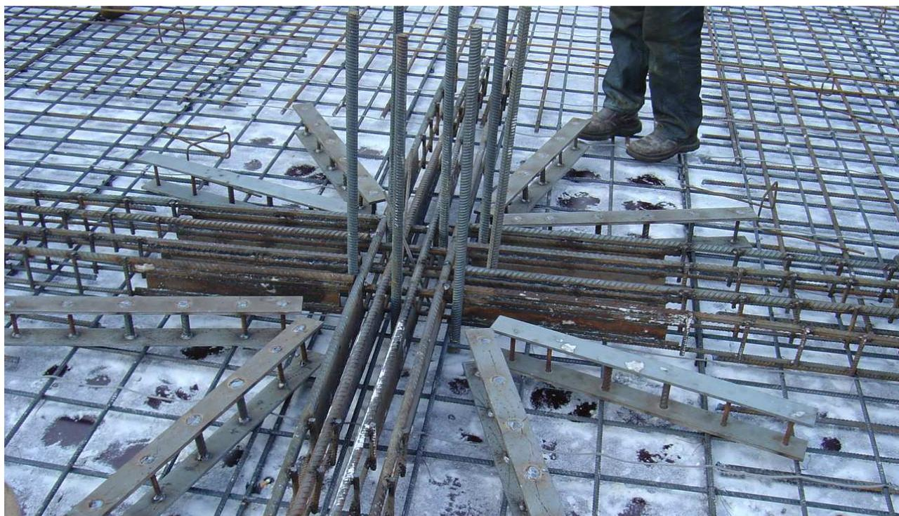
Рисунок 1.18. Распредсистема с жёсткой арматурой и радиальным дополнительным поперечным армированием в месте установки (по В.Д. Кузнецову)
