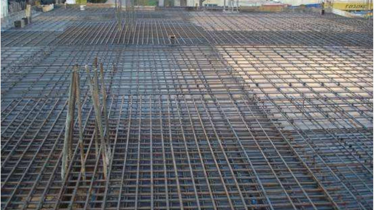
Рисунок 1.13. Общий вид арматурного поля (распределительная система по Л.Л. Кукше)
