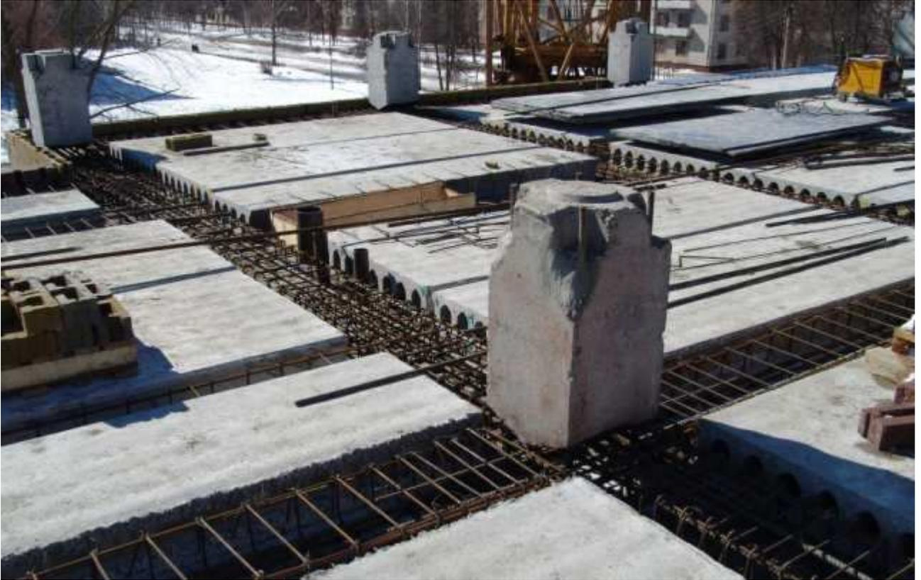
Рисунок 1.9. Фрагмент сборно-монолитного перекрытия по серии Б1.020.1-7
