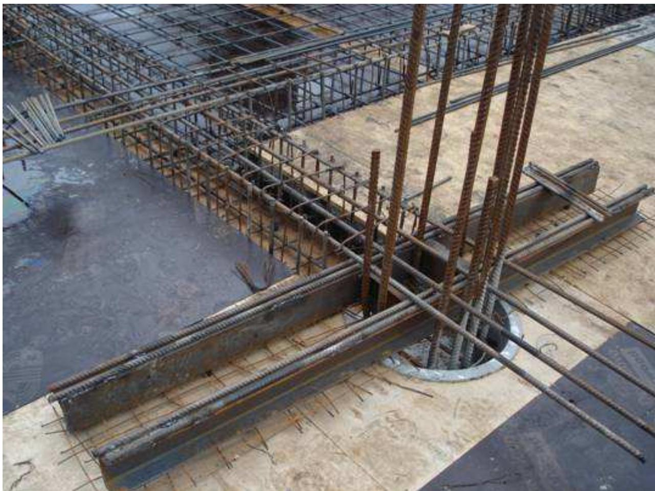
Рисунок 1.12. Распределительная система в месте установки (по Л.Л. Кукше)
