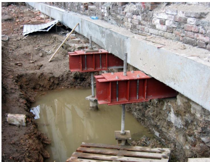
Подведение балок под обвязочный пояс и передача нагрузки на сваю.
