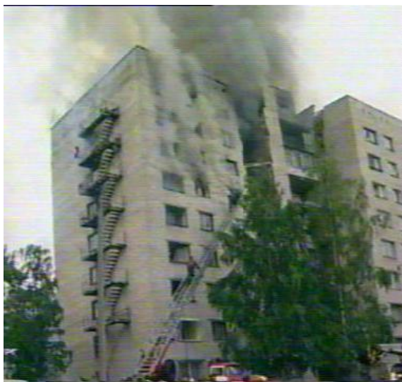
Дом на Двинской ул. перед обрушением
