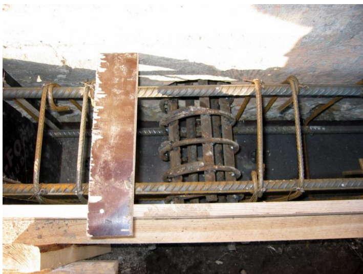
Армирование обвязочного пояса.
