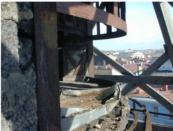
Металлокирпичные конструкции «Дома Книги»
