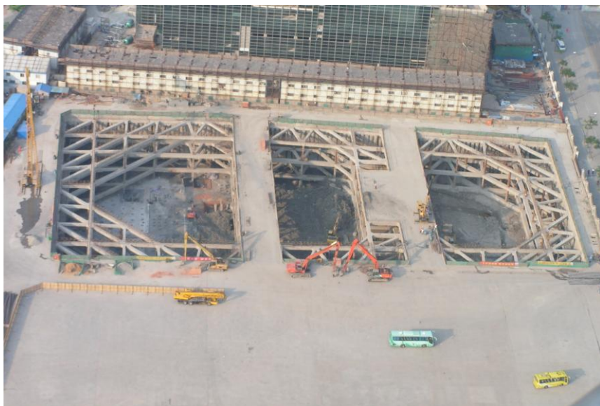
Временные железобетонные распорные конструкции при строительстве подземного сооружения в Шанхае.
