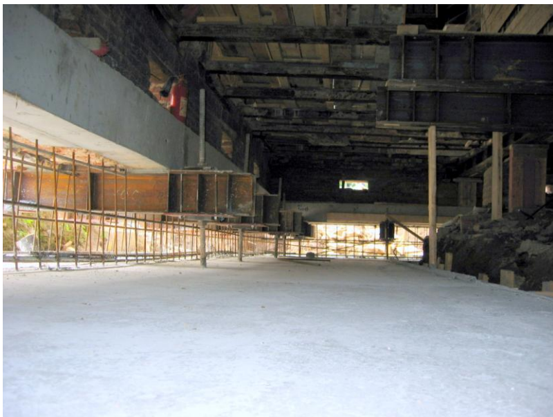
Устройство верхней плиты.
