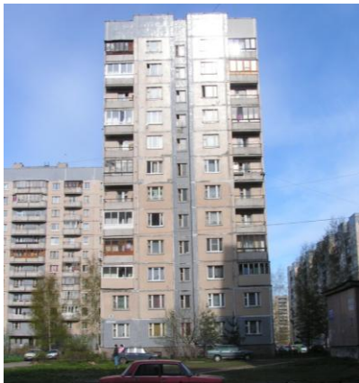
Последствия экономии длины свай: крен дома, трещины в панелях, осадки почти в 0,5 м!
