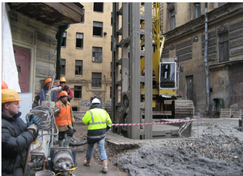
Зоологический пер. Первый опыт устройства стены в грунте в близком примыкании к существующим зданиям (эксперимент проводился на зданиях, подлежащих разборке)
