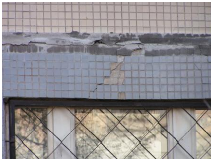
Последствия экономии длины свай: крен дома, трещины в панелях, осадки почти в 0,5 м!
