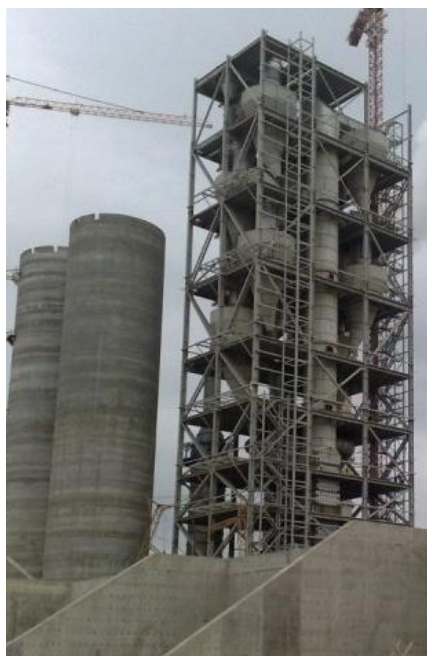
Расчетная схема конструкций силосов и возведенные конструкции промышленных небоскребов: 130-метрового «холодного конца печи» и силосов высотой 80 м.
