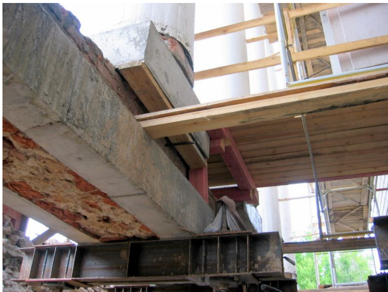
Вся нагрузка передана на сваи. Старые фундаменты разобраны.
